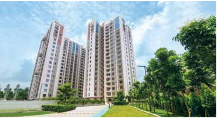
OZONE On South EM Bypass
